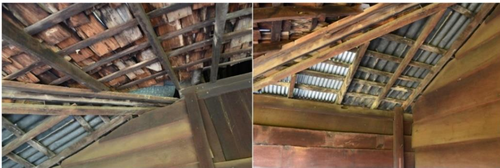
ภาพที่ 2.9 โครงสร้างและวัสดุมุงหลังคาที่มีทั้งไม้แป้นเกล็ด สังกะสี และกระเบื้องลอนผสมกัน
