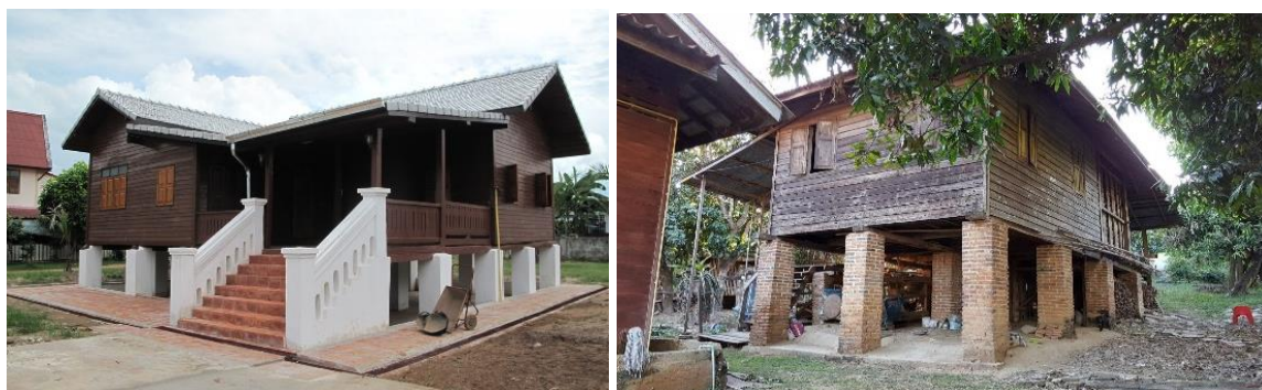
ภาพที่ 2.42 เรือนยกใต้ถุนสูงโดยใช้เสาอิฐก่อในกุฏิเจ้าอาวาสวัดสภารส และเรือนพักอาศัยโบราณ
