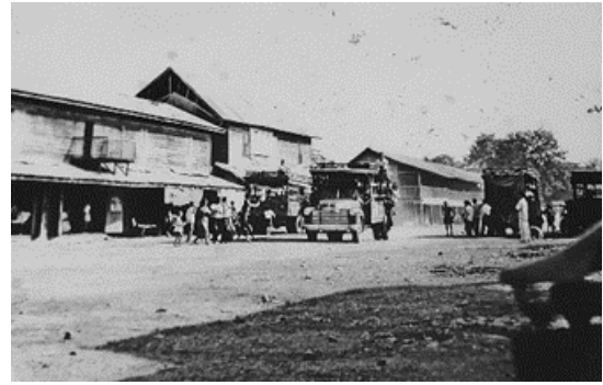
ภาพที่ 2.23 ห้องแถวไม้สองชั้นที่มีการต่อเติม ระเบียงด้านหน้าบนชั้นสองขึ้นภายหลัง
