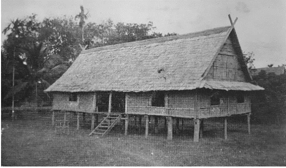
ภาพที่ 2.32 เรือนไม้บัวยกใต้ถุนสูงพอพื้นดิน สร้างขึ้น ในปี พ.ศ.2453 เพื่อเป็นโอรังสอนของโรงเรียนหญิง (โรงเรียนน่านคริสเตียนศึกษาในปัจจุบัน)
