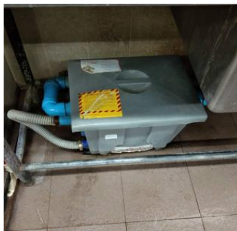
ภาพที่ ๑๓ ตะแกรงดักเศษอาหาร บ่อดักไขมัน และการดูดไขมันทิ้ง
