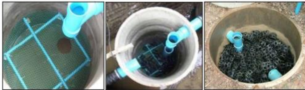
ภาพที่ ๔๑ การติดตั้งชิ้นตัวกรองในระบบกรองไร้อากาศ
