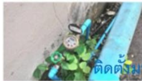
มาตรน้ำสำหรับแผนกซักล้าง
