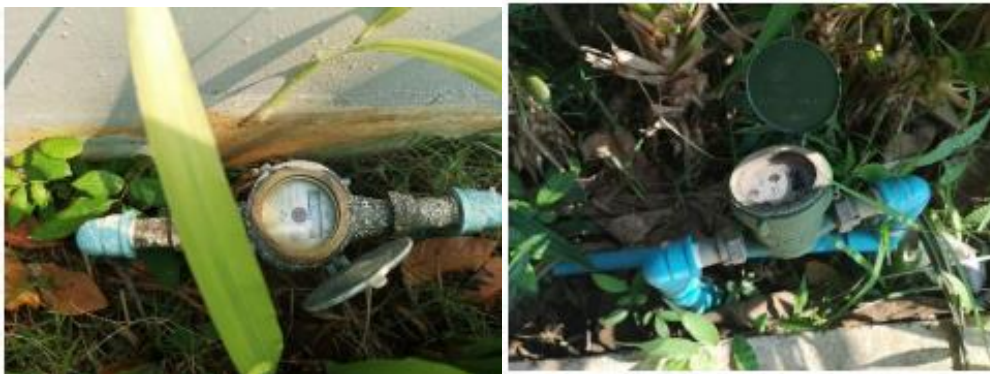
ภาพที่ ๕๓ การติดตั้งมาตรวัดน้ำแต่ละจุดที่มีการใช้น้ำ
