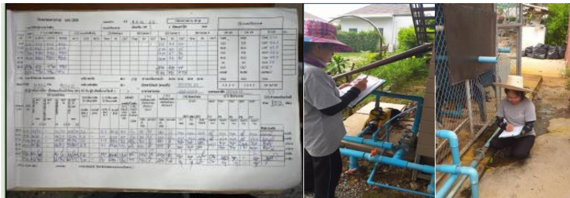
ภาพที่ ๕๐ การจดบันทึก และการตรวจสอบการรั่วไหลของท่อน้ำ
