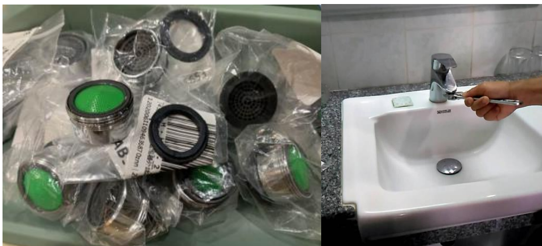
ภาพที่ ๔๗ การใช้อุปกรณ์ในการลดการไหลของน้ำ
